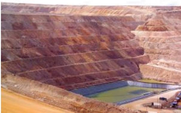
La base del PAD está recubierta por una geomembrana, que es un material plástico de alta resistencia que impide el contacto de los químicos con el suelo, cuidando la calidad del agua.
